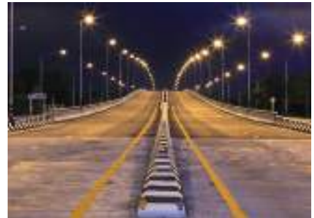
Éclairage d'autoroute par des lampes de vapeur de sodium, de couleur orangée.
